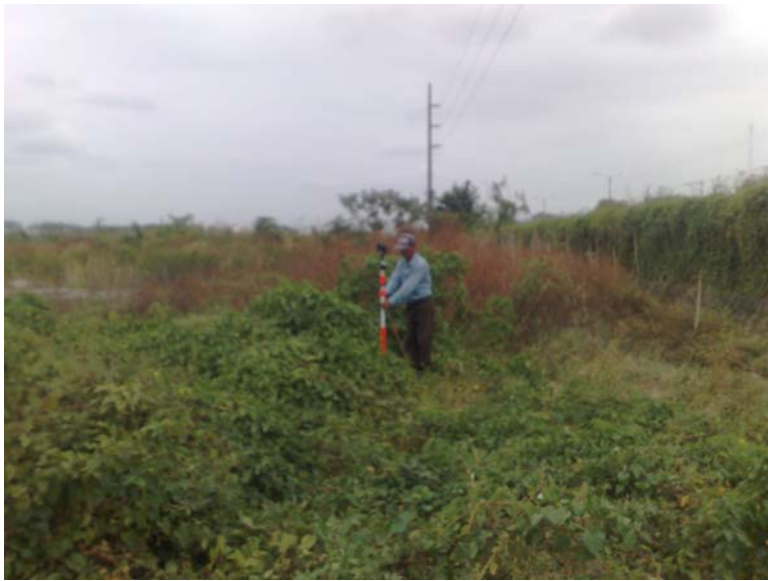
CADENERO UTILIZANDO PRISMA CON LA ESTACION TOTAL
